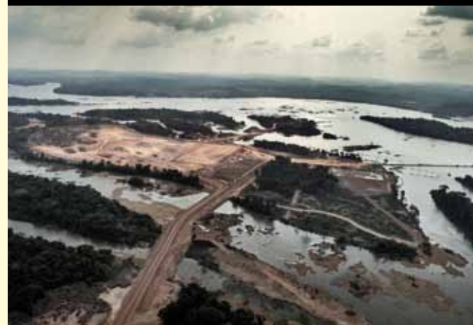
Expansion du barrage de Belo Monte, en 2012
